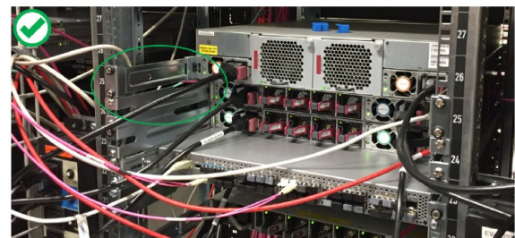
Befestigung des Schrankinhalts [Risk&Safety AG]
